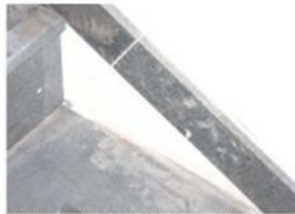
Foto 16. Detalj skiferfiser på trapp og sokkellist Et område manglet skifer og avslørte lim som rent ned i fugen.
