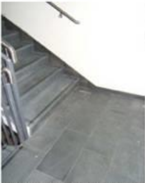
Foto 14. Detalj skiferfiser på trapp og sokkellist
