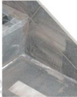
Foto 15. Detalj skiferfiser på trapp og sokkellist
