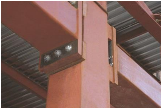
Figura 43 – Giunto tubolare con tasselli BoxBolt
