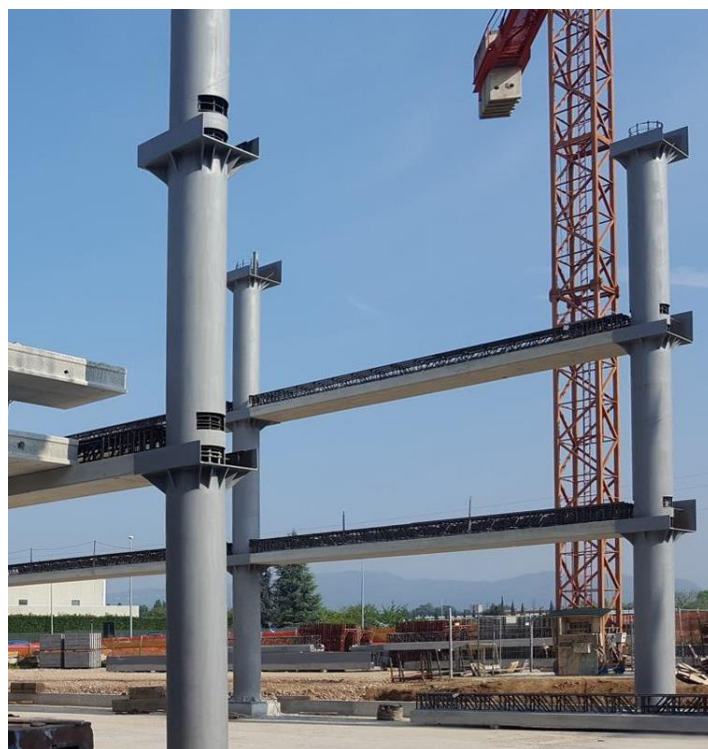
Figura 35 – Pilastri a nodo umido strutturale (NUS) uniti tra loro con giunti di inghisaggio e scarpe Peikko
