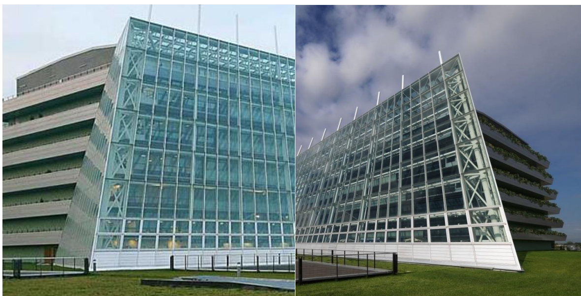
Figura 52 – Posizionamento dei controventi verticali
