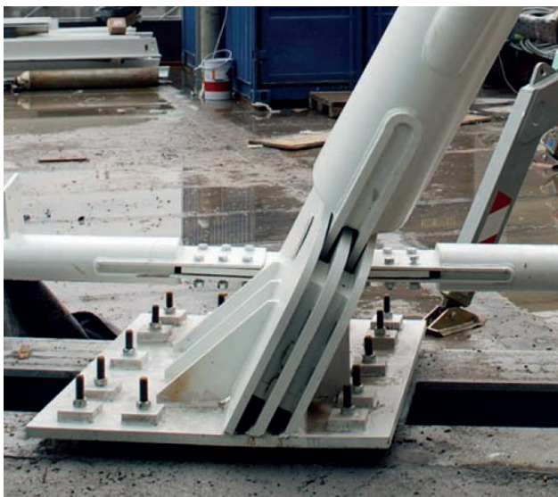
Figura 44 – Nodo di base con cerniera cilindrica,
