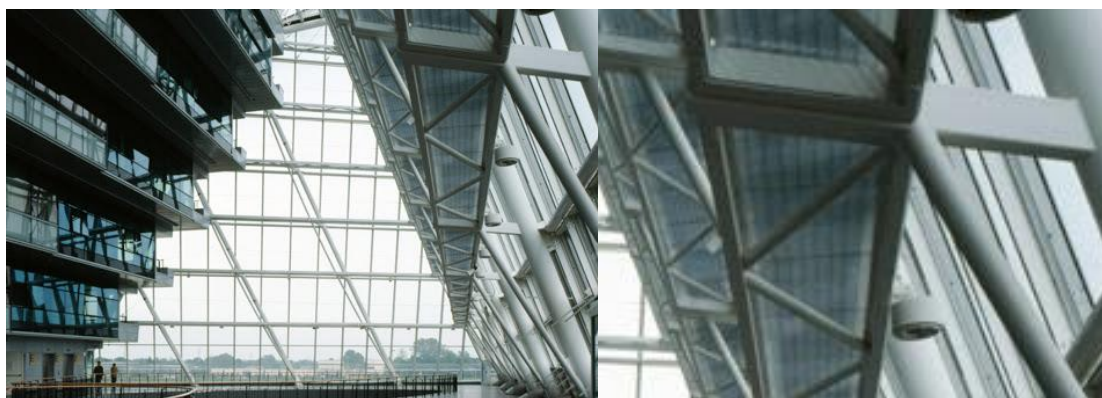
Figura 50 – Collegamento tra colonna ed elemento secondario
