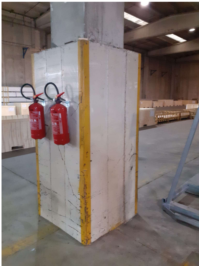
Fig.3.10: Ingrossamento pilastro
