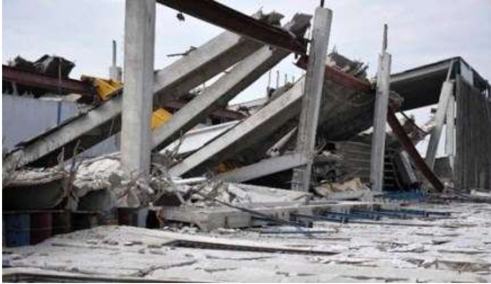
Fig.2.3, Fig.2.4: Capannoni crollati per eventi sismici in Emilia nel terremoto del 2012
