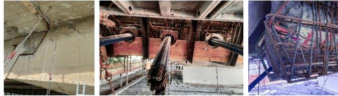
Il viadotto Akragas II è stato oggetto di un intervento di rinforzo strutturale degli impalcati e delle strutture superiori dei piloni, ovvero i pulvini. L'intervento più delicato è previsto sui pulvini e consiste nell'installazione di sei cavi in precompressione esterna per ciascun pulvino.
