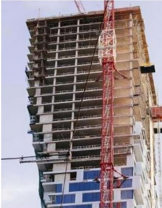
Nel progetto strutturale ideale i pilastri seguono un allineamento verticale continuo. Tuttavia, layout architettonici complessi richiedono spesso variazioni nella disposizione delle colonne tra i piani. In questi casi, le *Walking Columns* rappresentano una soluzione efficace e discreta rispetto a travi di trasferimento o colonne inclinate.
